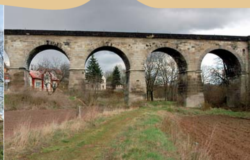
ŽELEZNIČNÍ MOST V PODLEŠÍNĚ
